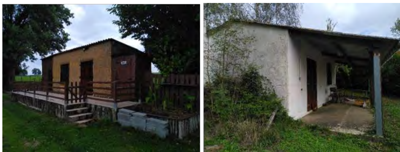
Figure 267 : Bâti non habité au sein de l'AEI (Source : VALECO)
